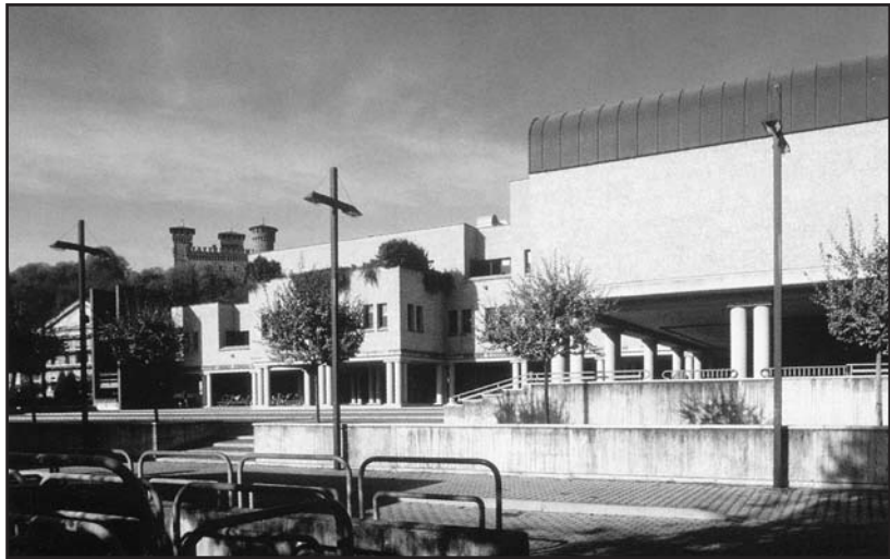
Il nuovo palazzo municipale di Montichiari, costruito nei primi anni '90 (1991-1995) sull'area del vecchio mercato del bestiame. L'opera costò al tempo quasi undici miliardi di lire e fu inaugurata il 12 maggio 1996. (BAMS - Matteo Rodella)
